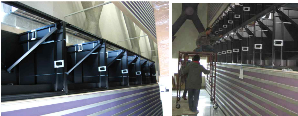
[그림 2-3] 대형 표시반을 고정시키는 프레임
