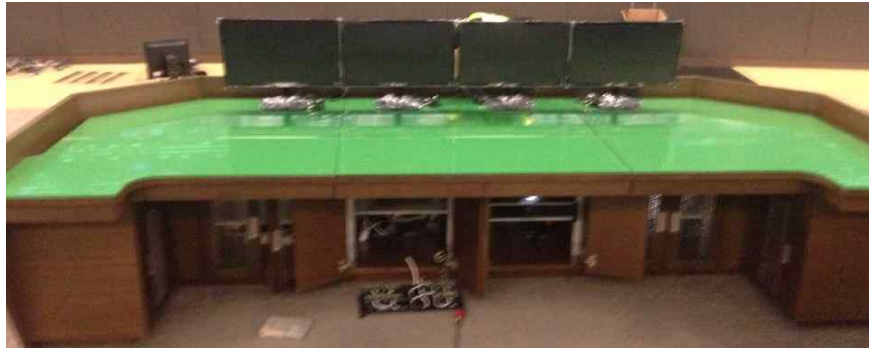
출처: 제작사 시스템설명서(대아티아이(주)) [그림 2-9] 관제사 콘솔에 CTC 장치를 장착하는 과정의 모습
