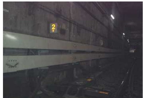
00역 터널 내 시공
