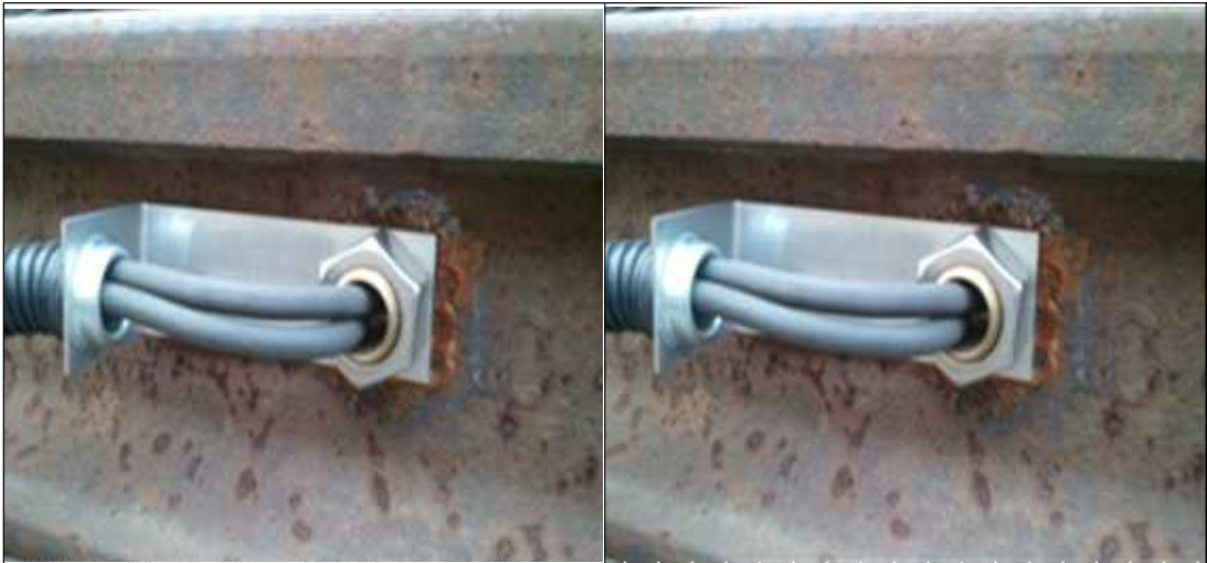
[그림 3-4] 레일히터 설치
