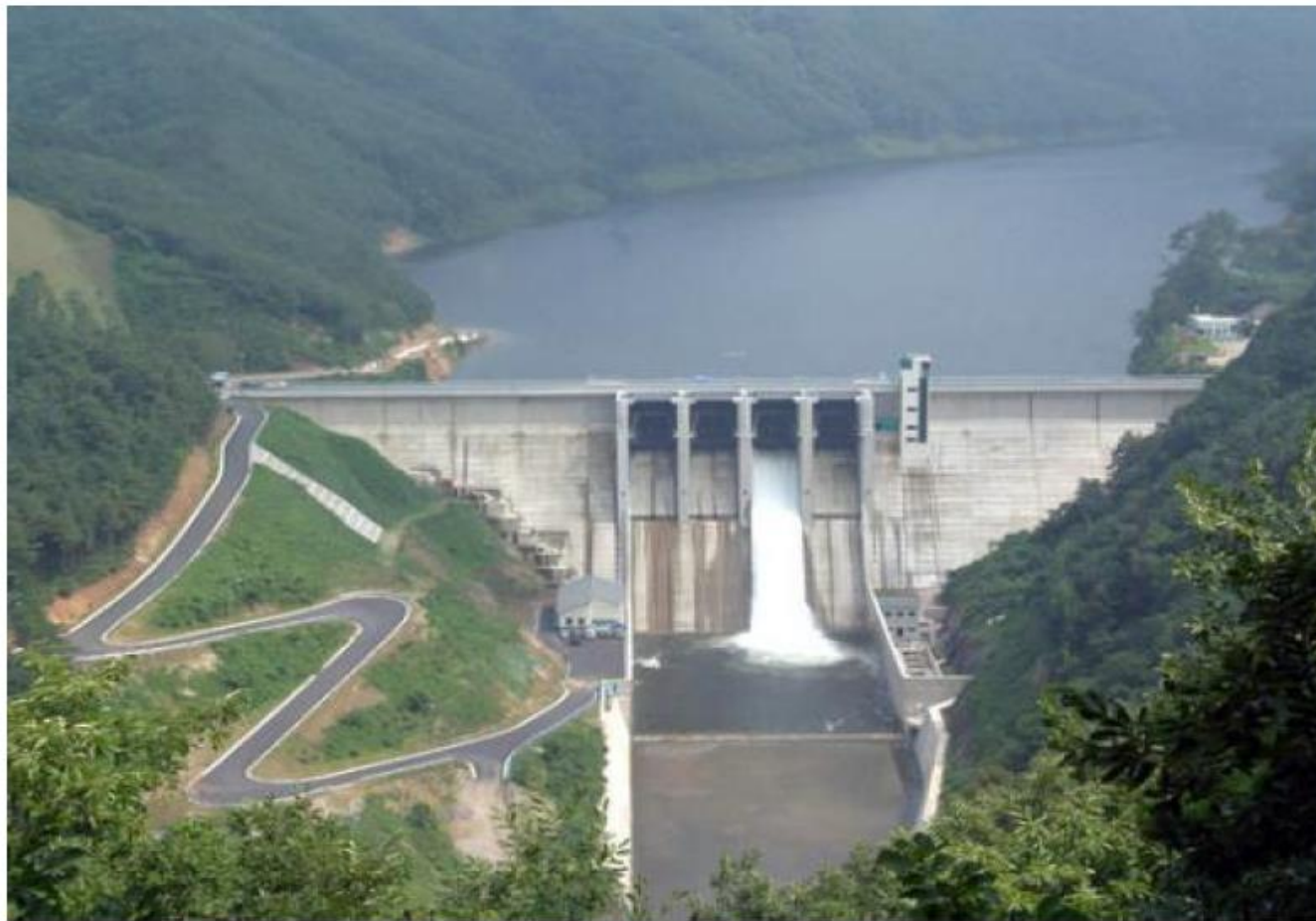
양양 양수발전소 - 세계 최대 규모 (1,000 MW)
